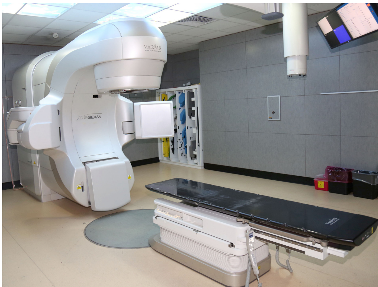
Acelerador lineal, que se encuentra en la Unidad de Radio-Oncología
